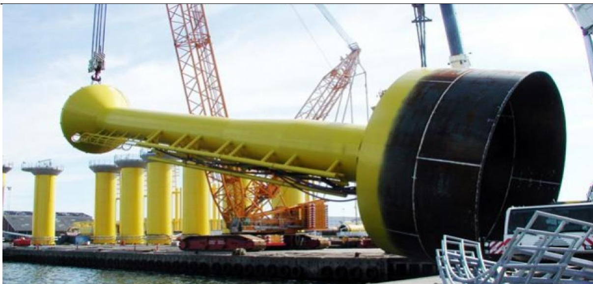
Slika 14. Primjer temelja s usisnom kantom [13]
