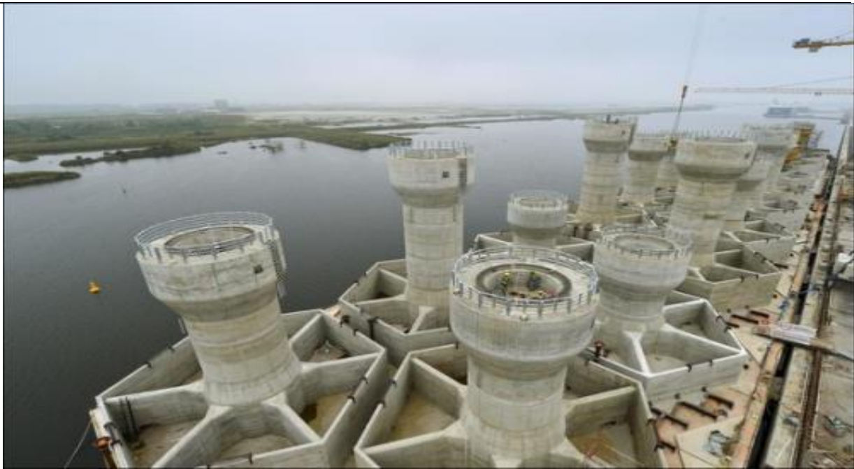
Slika 10. Primjer temelja s gravitacijskom betonskom bazom [9]
