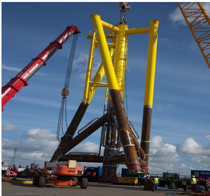
Slika 13. Primjer uvijenih temelja [12]
