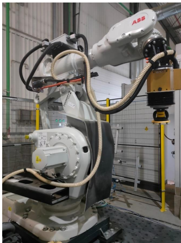
Slika 2. Robot ABB IRB 6660-205-1.9 s prigronom za brušenje u robotskoj obradnoj ćeliji
