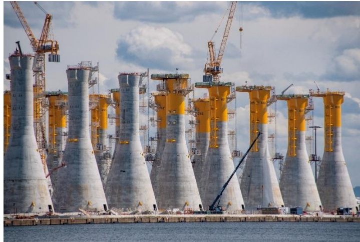
Slika 45. Gravitacijski temelji [30]
