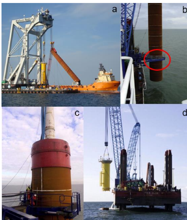
Slika 43. Prikaz ugradnje pilotnog temelja [22]
