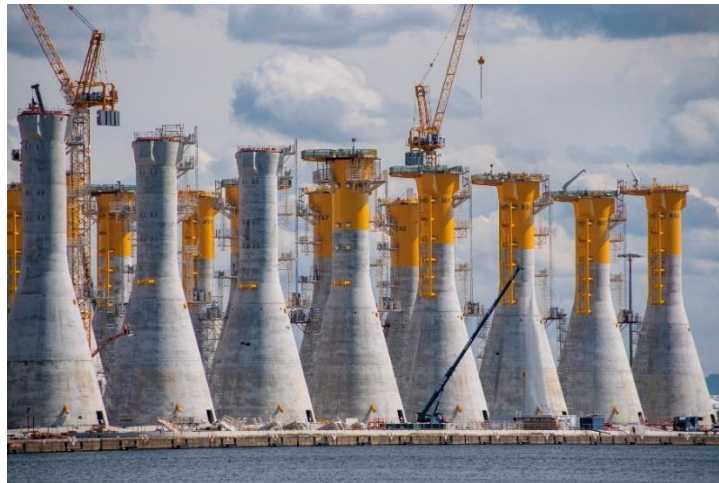
Slika 45. Gravitacijski temelji [30]
