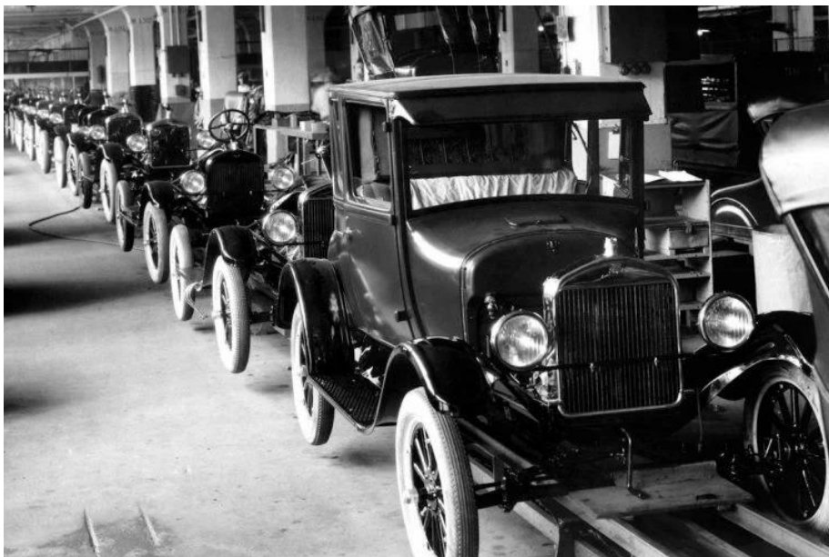
Slika 2. Pokretna linija za automobil Ford T [5]
