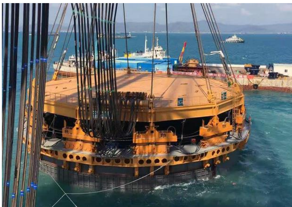
Slika 12. Hidraulički vibracijski zabijač APE DodecaKong [22]
