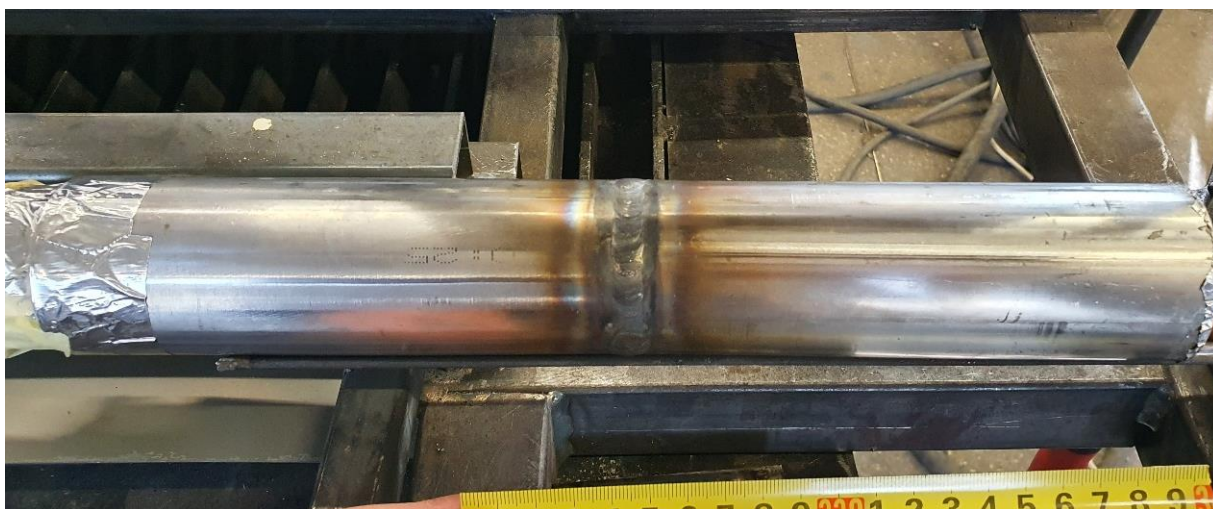
Slika 9. Postavljanje cijevi na uređaj za zavarivanje
