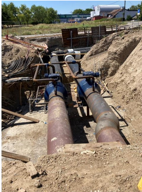
Slika 7. Prikaz novo ugrađenih ventila za magistralni vod – Slikano tijekom industrijske prakse u HEP Toplinarstvu
