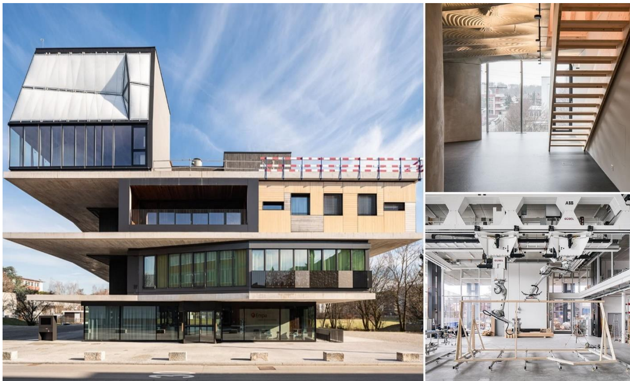
Slika 23. Trodimenzionalno ispisana zgrada [25]
