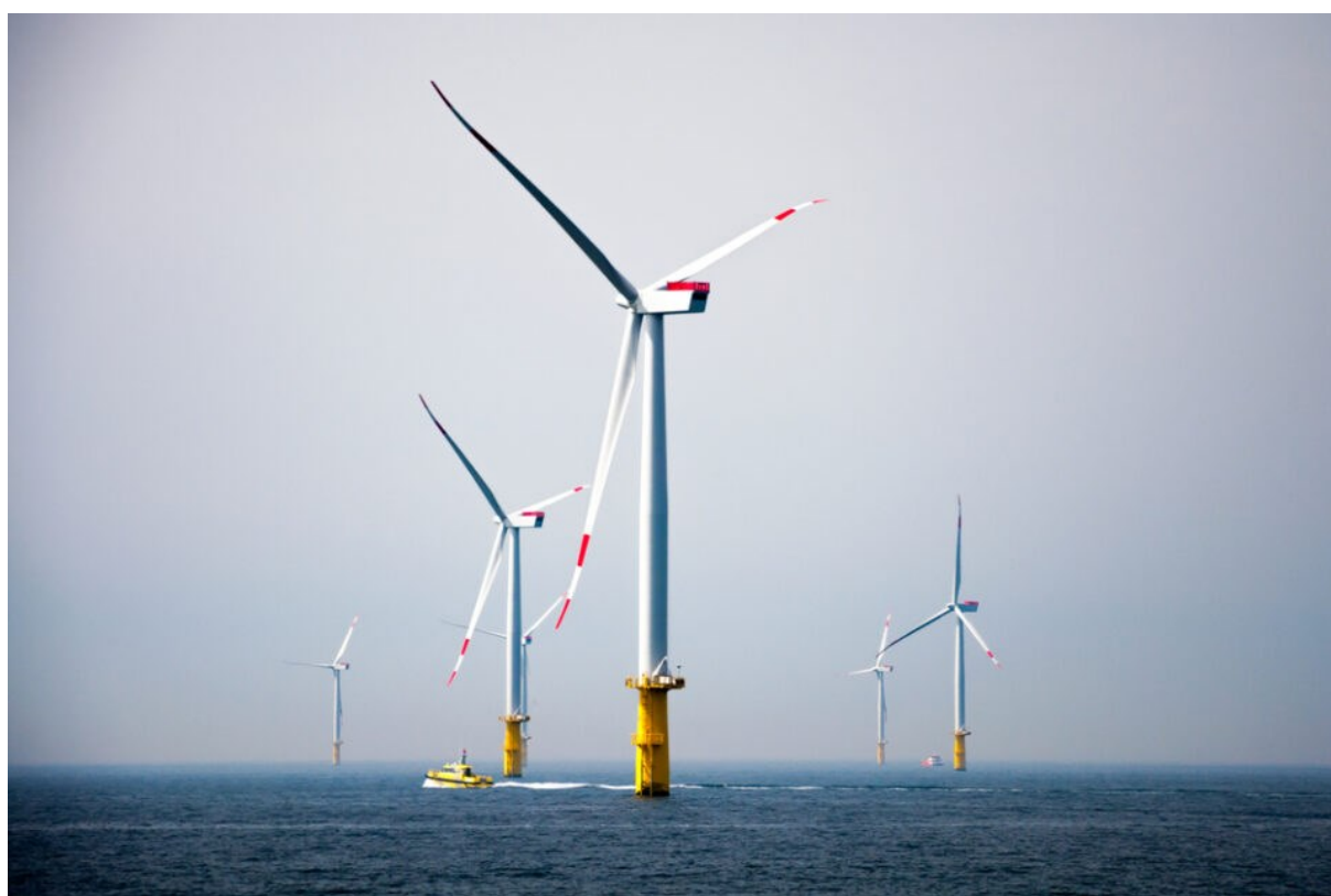
Slika 1. Vjetroelektrane na pučini mora
