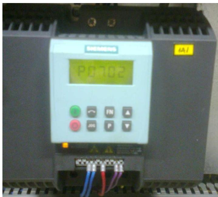
Slika 3.3 Frekvencijski pretvarač sa aktiviranim modom P702
