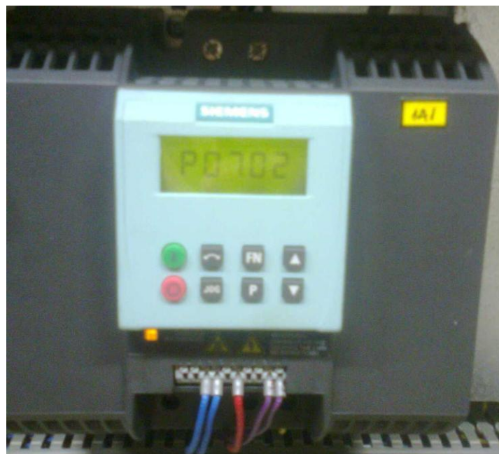
Slika 3.3 Frekvencijski pretvarač sa aktiviranim modom P702
