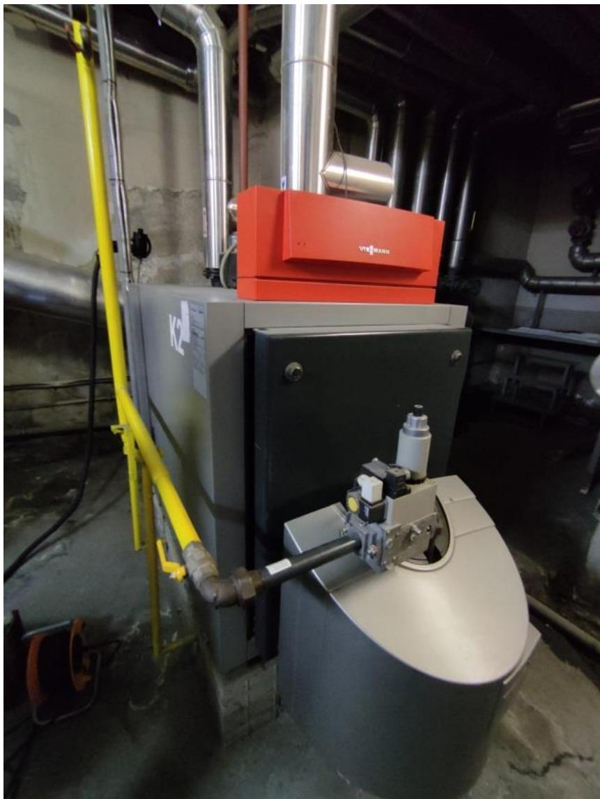
**Slika 3.** Toplovodni kotao proizvođača Viessmann (tip Vitoplex 200)
