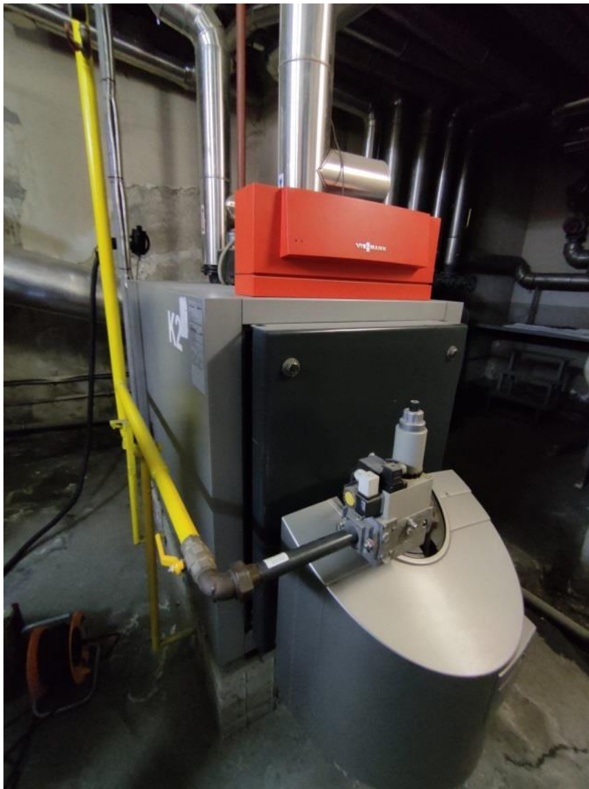
Slika 3. Toplovodni kotao proizvođača Viessmann (tip Vitoplex 200)
