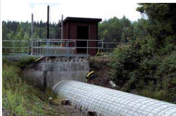
Slika 4.4: Bångbro, Sweden - kontrola dovoda vode na turbinu
