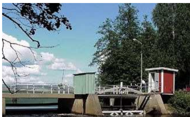
Slika 4.1: Kläggen, Švedska – sustav upravljanja segmentnim zatvaračima za kontrolu razine jezera
