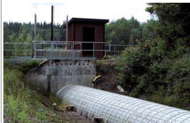
*Slika 4.4: Bångbro, Sweden - kontrola dovoda vode na turbinu*
