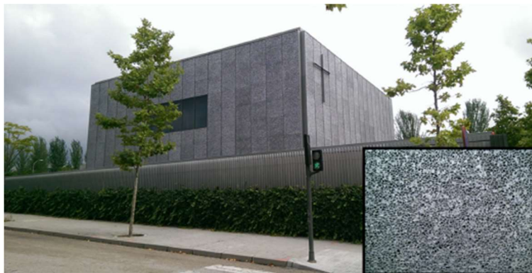
Slika 34 Protstantska crkva u Španjolskoj s fasadom od alumijeve pjene [14]
