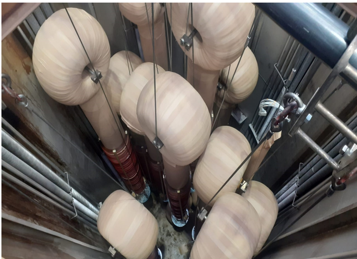
Slika 3.8 Proces sušenja transformatora
