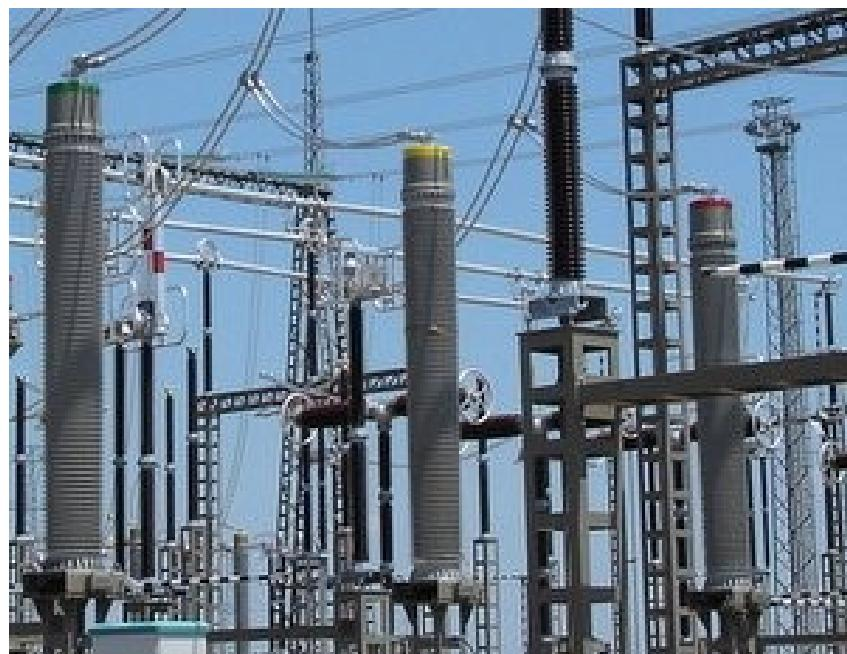
Slika 2.9 Visokonaponski mjerni transformator [19]
