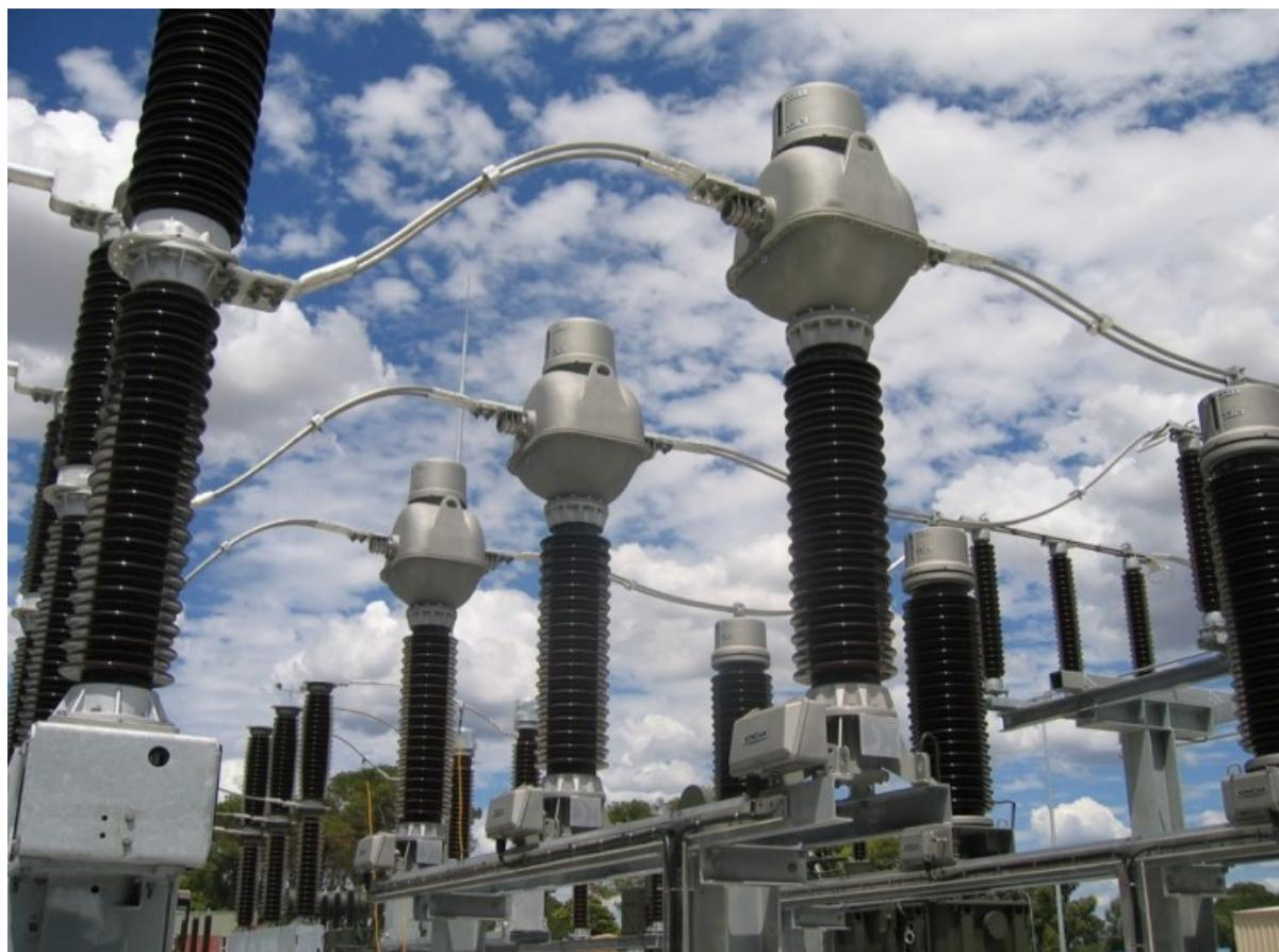
**Slika 2.10 Strujni transformator – AGU [19]**
