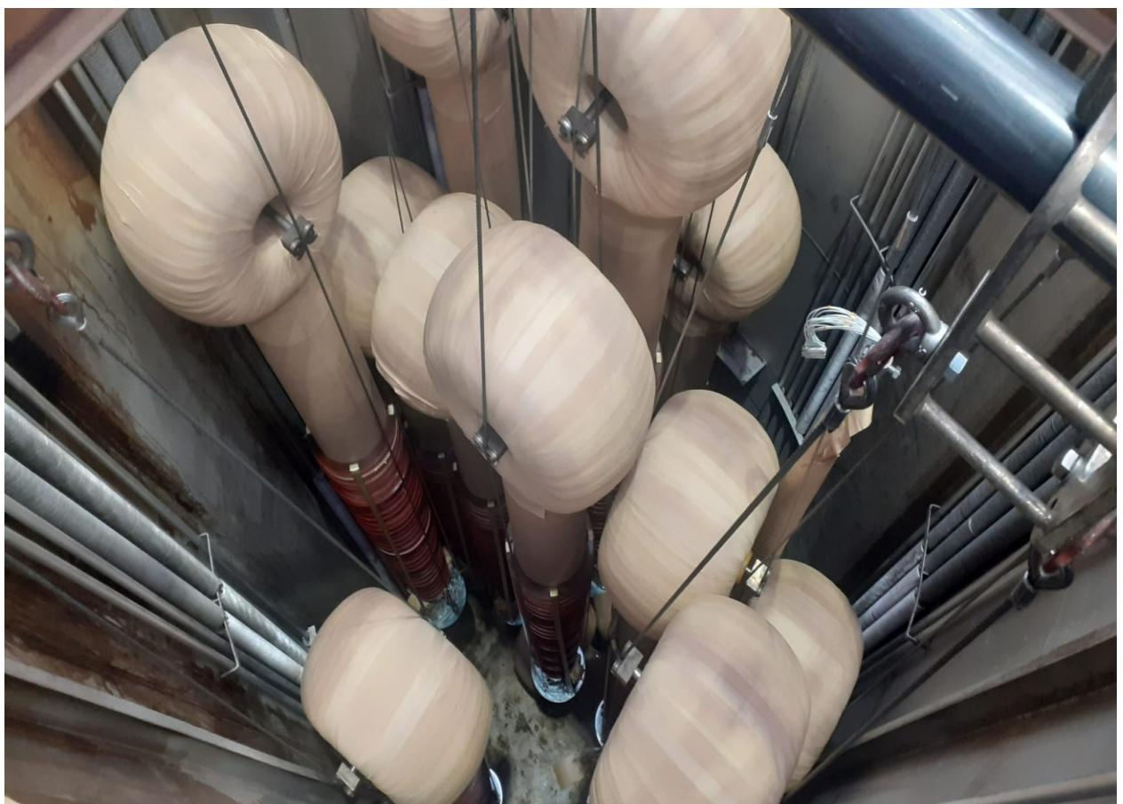
**Slika 3.8 Proces sušenja transformatora**
