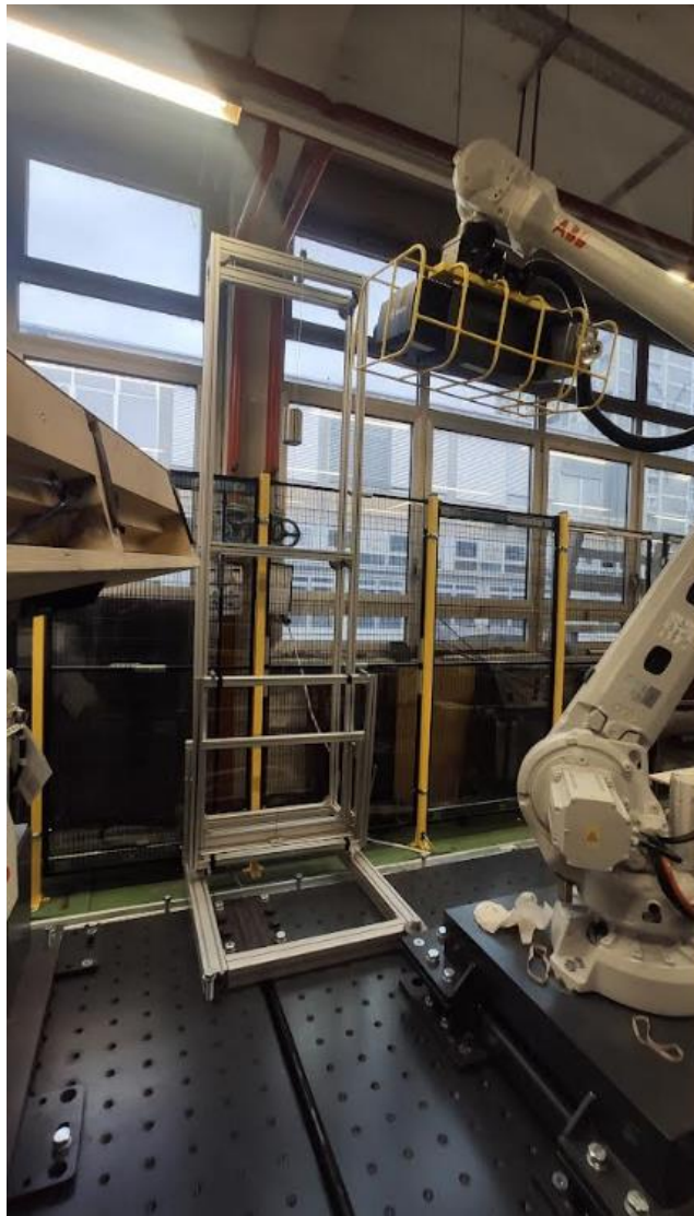
Slika 48 Montirana naprava za prihvat kalibracijskih ploča
