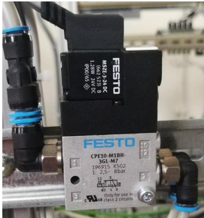
Slika 41. Elektroventil CPE10-M1BH-3GL-M7
