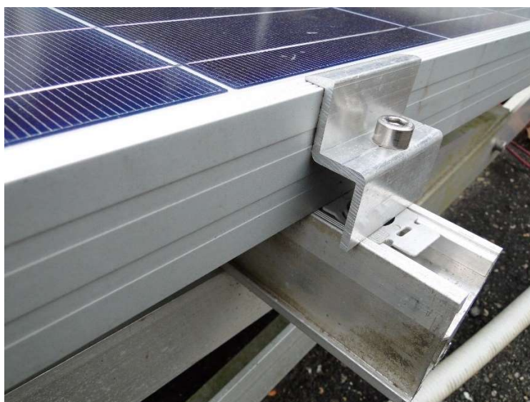
Slika 7 Okvir fotonaponskog modula [9]
