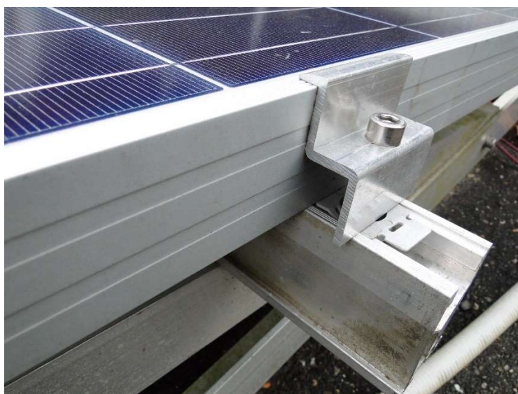
Slika 7 Okvir fotonaponskog modula [9]
