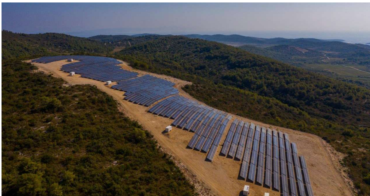
Slika 19 Fotonaponska elektrana otoka Visa [34]
