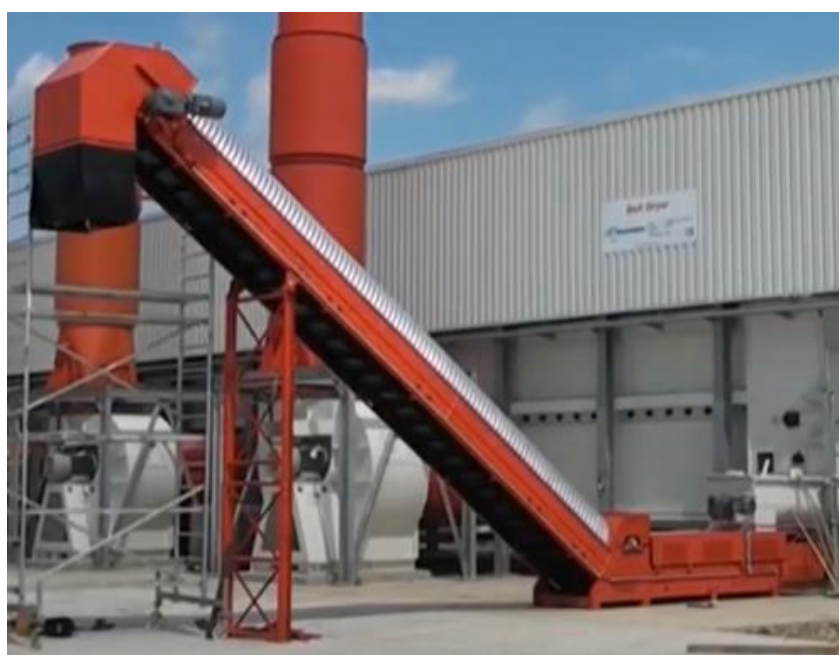
Slika 22. Konvejer za drvenu sječku u termoelektrani Slatina [16]
