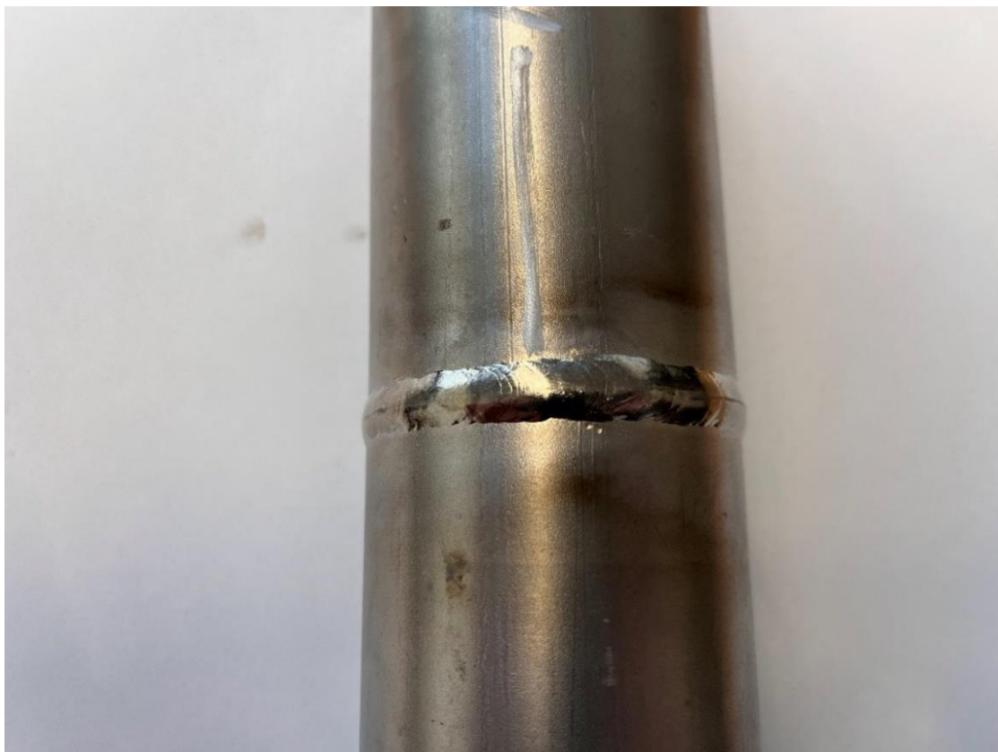
Slika 19. Detalj zavarenog spoja na cijevi od nelegiranog titanija
