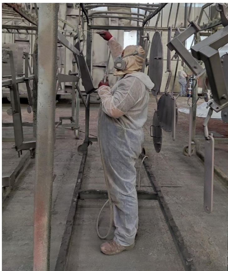
Slika 14. Nanošenje premaza pridržavajući se zaštite na radu, Končar Metalne Konstrukcije
