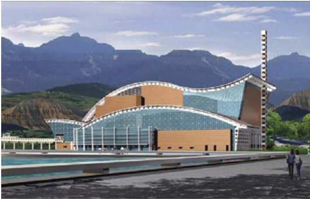
Slika 2.15. Buduća Energana na otpad u Shenzhenu, Kina [10]
