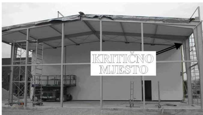
Slika 13. Položaj mjesta kritičnog naprezanja.
