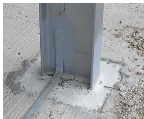
Slika 42. Detalj spoja stupa i temelja.
