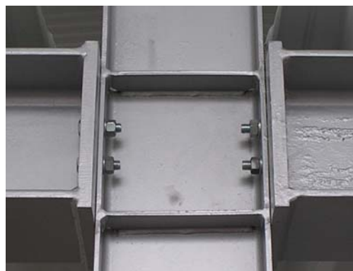
Slika 19. Detalj spoja konstrukcije.
