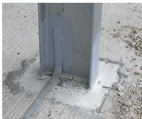
Slika 42. Detalj spoja stupa i temelja.
