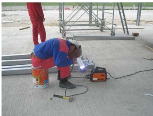
Slika 9. Zavarivanje na mjestu montaže.
