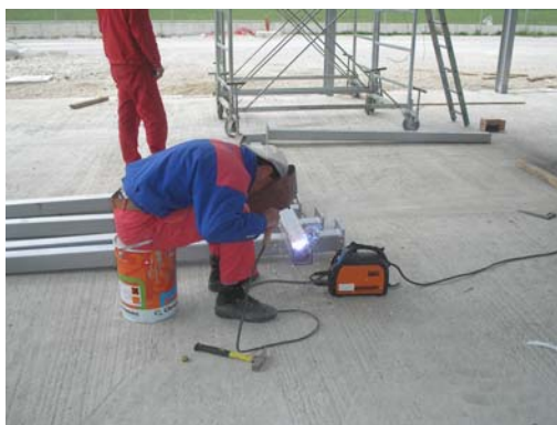
Slika 9. Zavarivanje na mjestu montaže.
