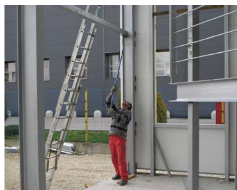
Slika 10. Popravak antikorozivne zaštite.
