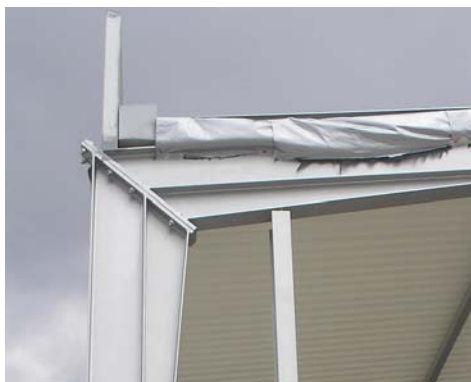
Slika 41. Detalj spoja stupova i greda.
