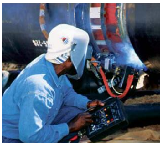
Slika 6.7 Zavarivanje cjevovoda sustavom Pipeliner II [13]
