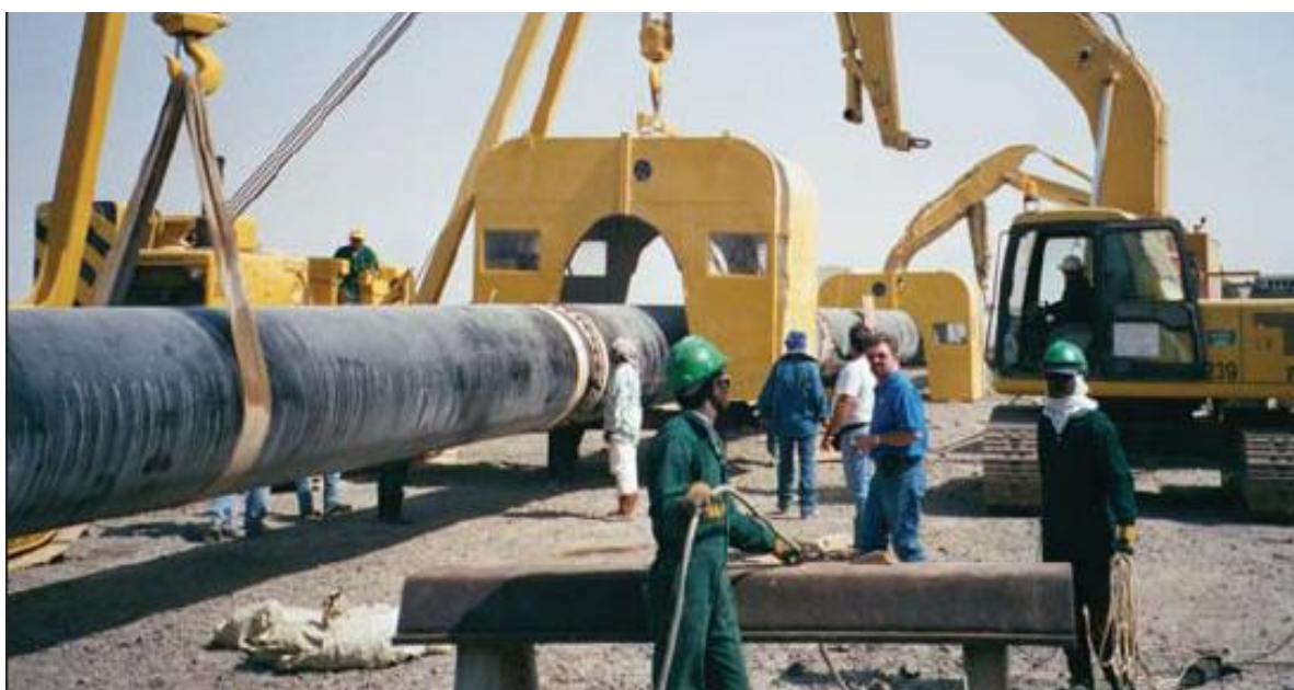
Slika 6.9 Zavarivanje cjevovoda promjera 1200 mm [13]
