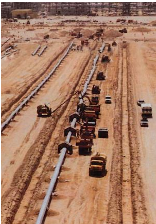
Slika 6.8 Zavarivanje plinovoda promjera 760 mm [13]
