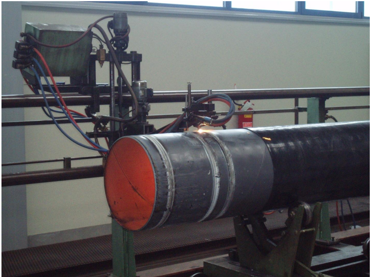
Slika 7.4 Rezanje cijevi automatskom plinskom rezačicom
