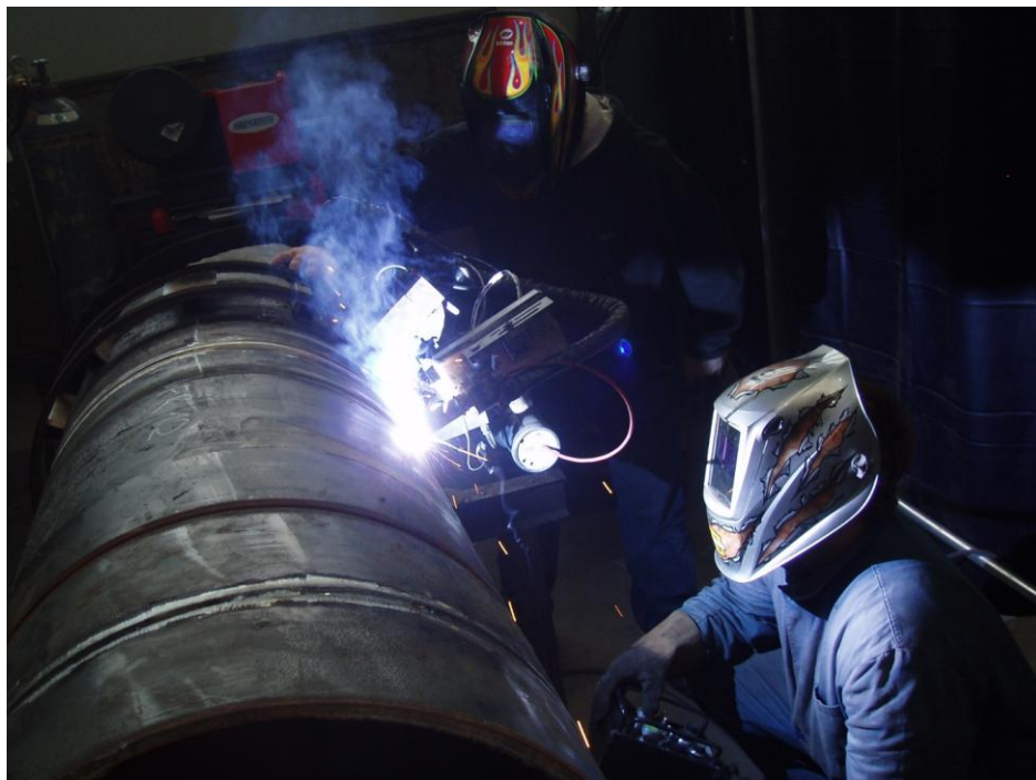
Slika 7.9 Zavarivanje Pipeliner II automatskim orbitalnim postupkom zavarivanja
