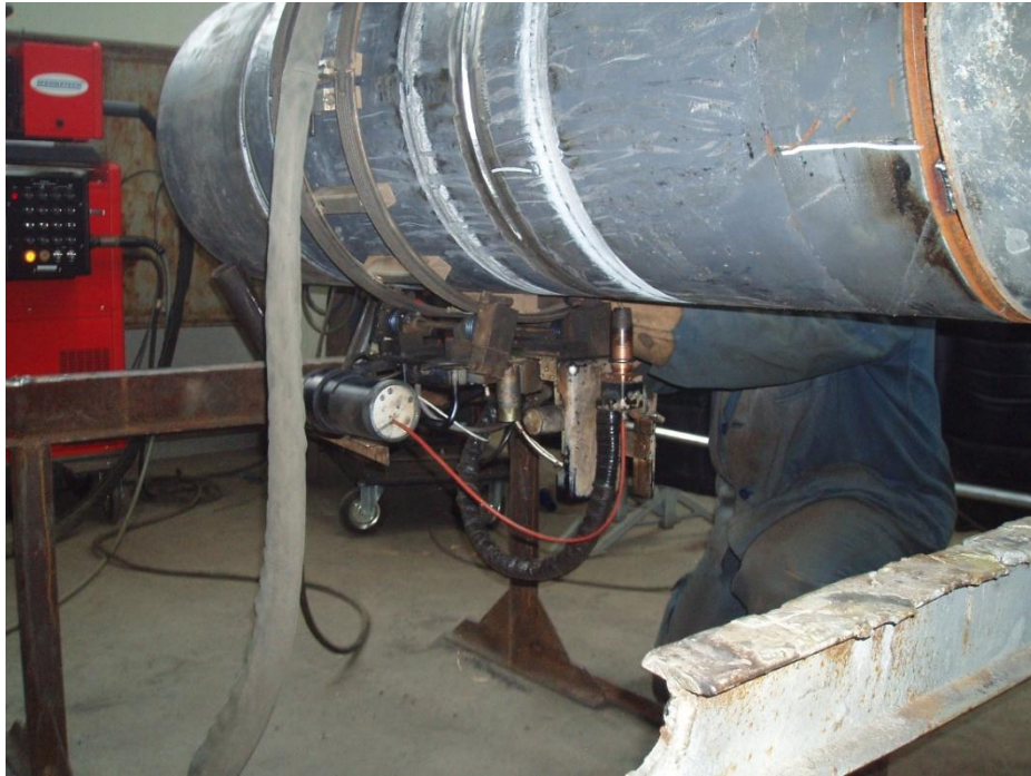
Slika 7.8 Početna pozicija zavarivanja za orbitalno zavarivanje Pipeliner II
