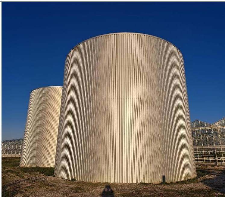
Slika 3-10: Dva toplinski izolirana buffer-a
