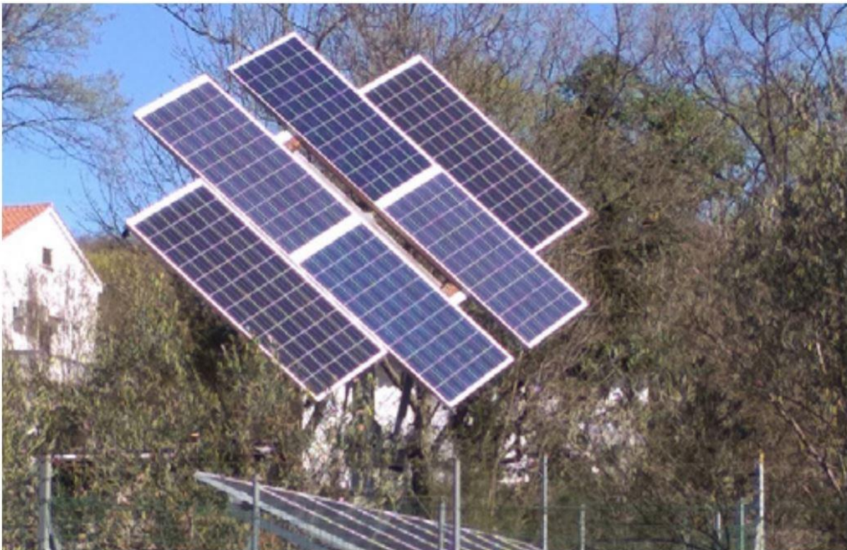
Slika 17. Dvoosni fotonaponski sustav [36]
