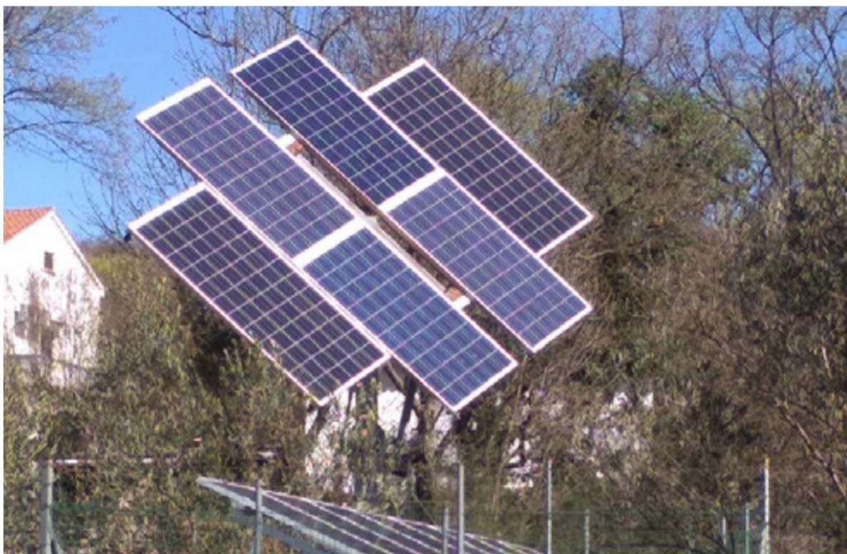
Slika 17. Dvoosni fotonaponski sustav [36]
