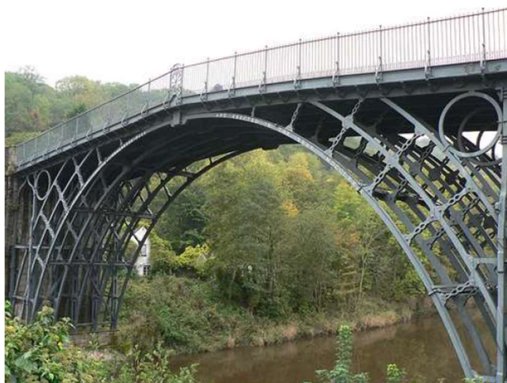
Slika 1. Prvi most izrađen od željeznog lijeva [1]
