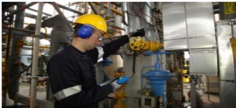
Slika 11. Inspekcija ventila bezkontaktnim senzorom [2]
