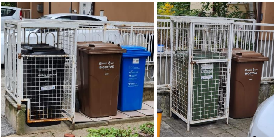
Slika 15. Rešetkasta konstrukcija s otvorom za spremnik za mješoviti komunalni otpad (lijevo) i rešetkasta konstrukcija koja potpuno onemogućuje neovlašteni pristup (desno)
