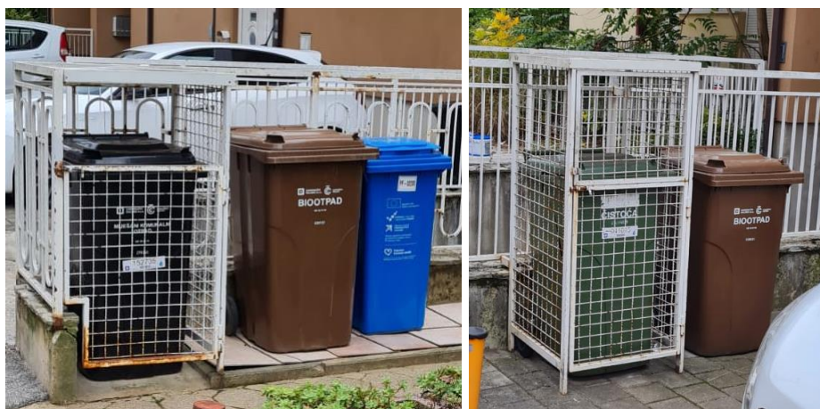
Slika 15. Rešetkasta konstrukcija s otvorom za spremnik za mješoviti komunalni otpad (lijevo) i rešetkasta konstrukcija koja potpuno onemogućuje neovlašteni pristup (desno)
