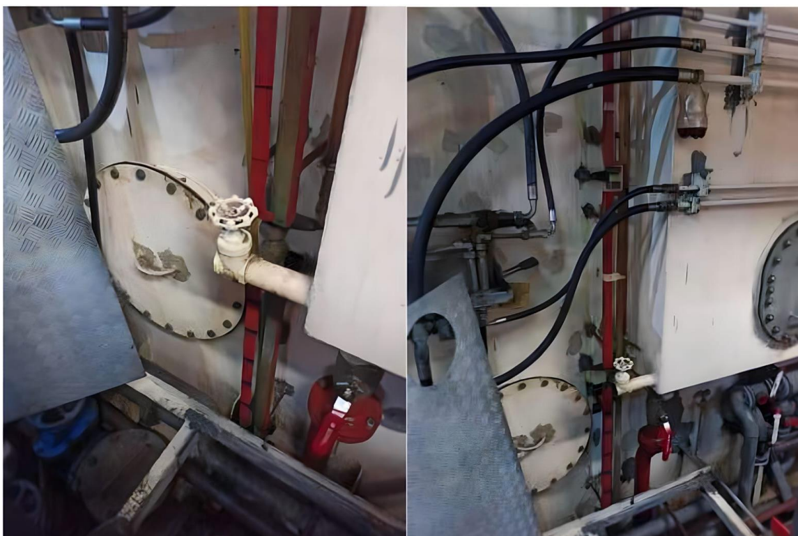
Slika 10. Ugrađeno mjerilo stanja spremnika na plivaričaru "Noa"
