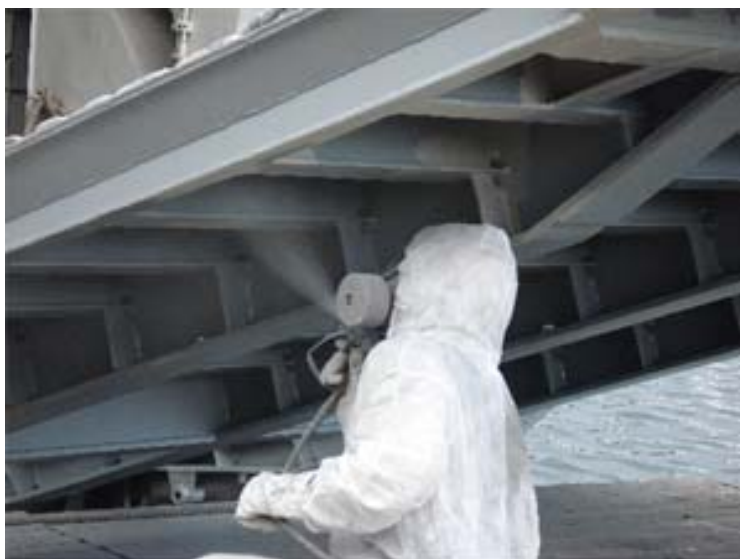
Slika 15. Nanošenje premaza bezračnim prskanjem [7]
