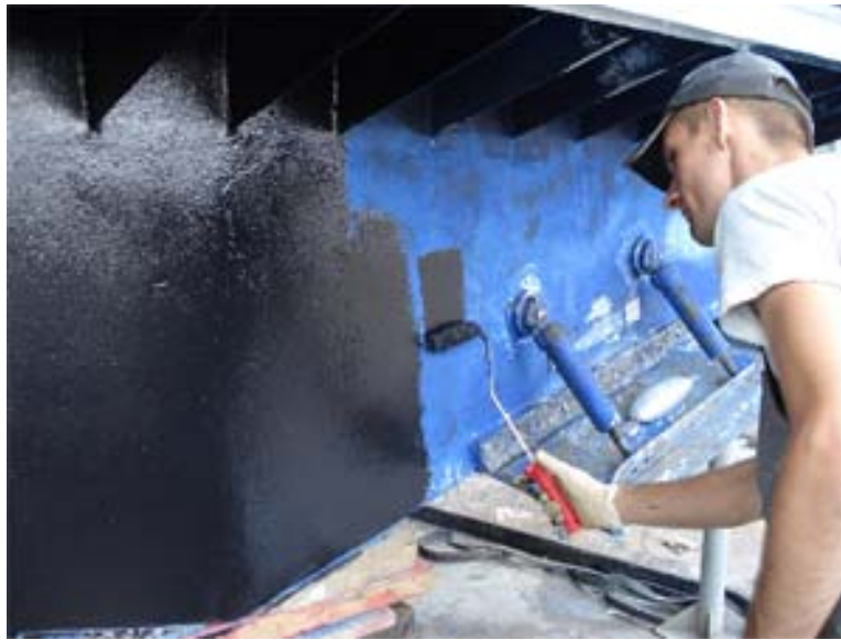
Slika 14. Nanošenje premaza valjkom [7]
