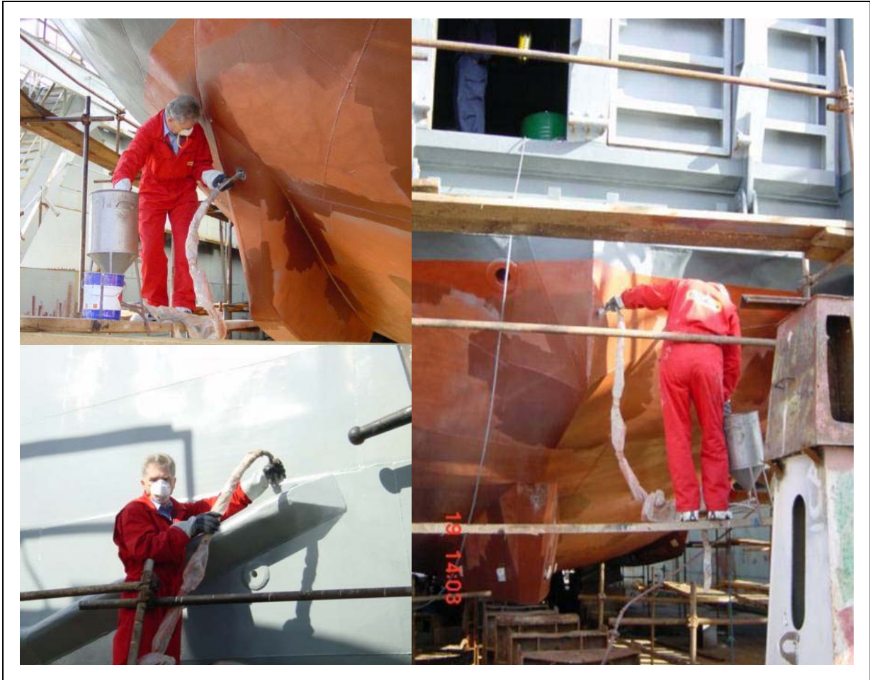
Slika 29. Zaštita kobilice, bokoštivnika i pramca broda praškastim hlapivim inhibitorima korozije [3]
