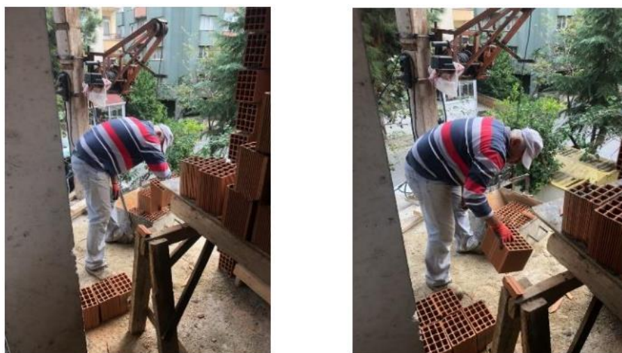
Slika 23. Obavljanje posla podizanja cigli na povišenu podlogu
