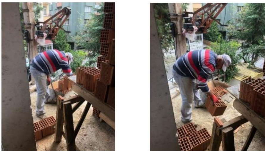
Slika 23. Obavljanje posla podizanja cigli na povišenu podlogu
