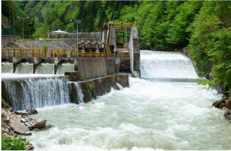
Slika 4.2 Primjer protočne HE
