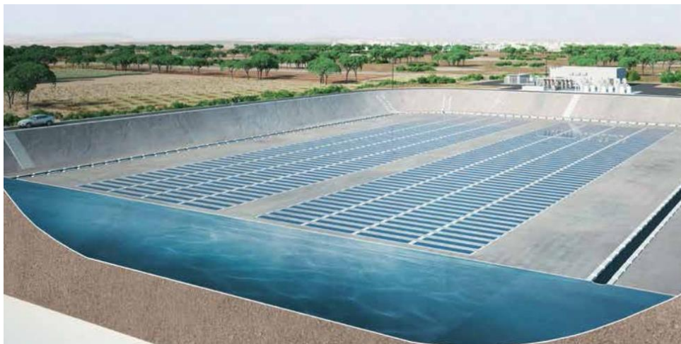
Slika 3.3 Primjer postavljenog FPV sustava na vodi [11]
