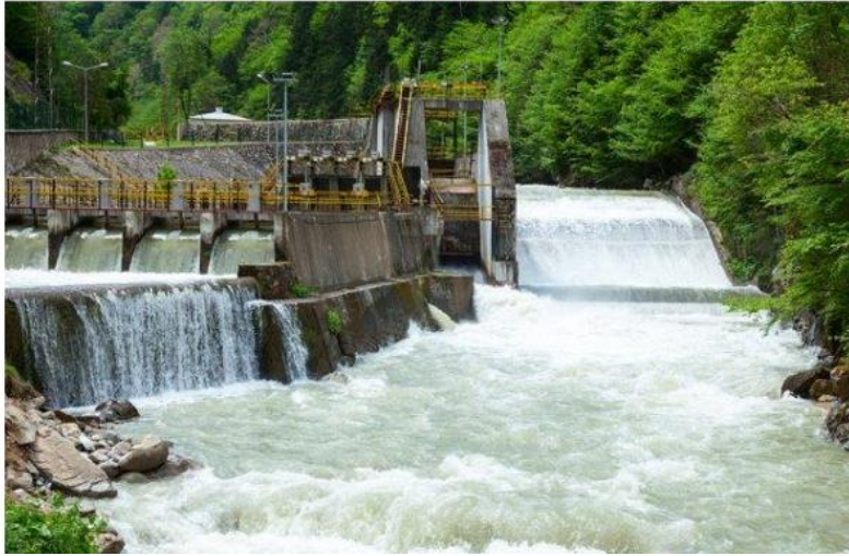
Slika 4.2 Primjer protočne HE
