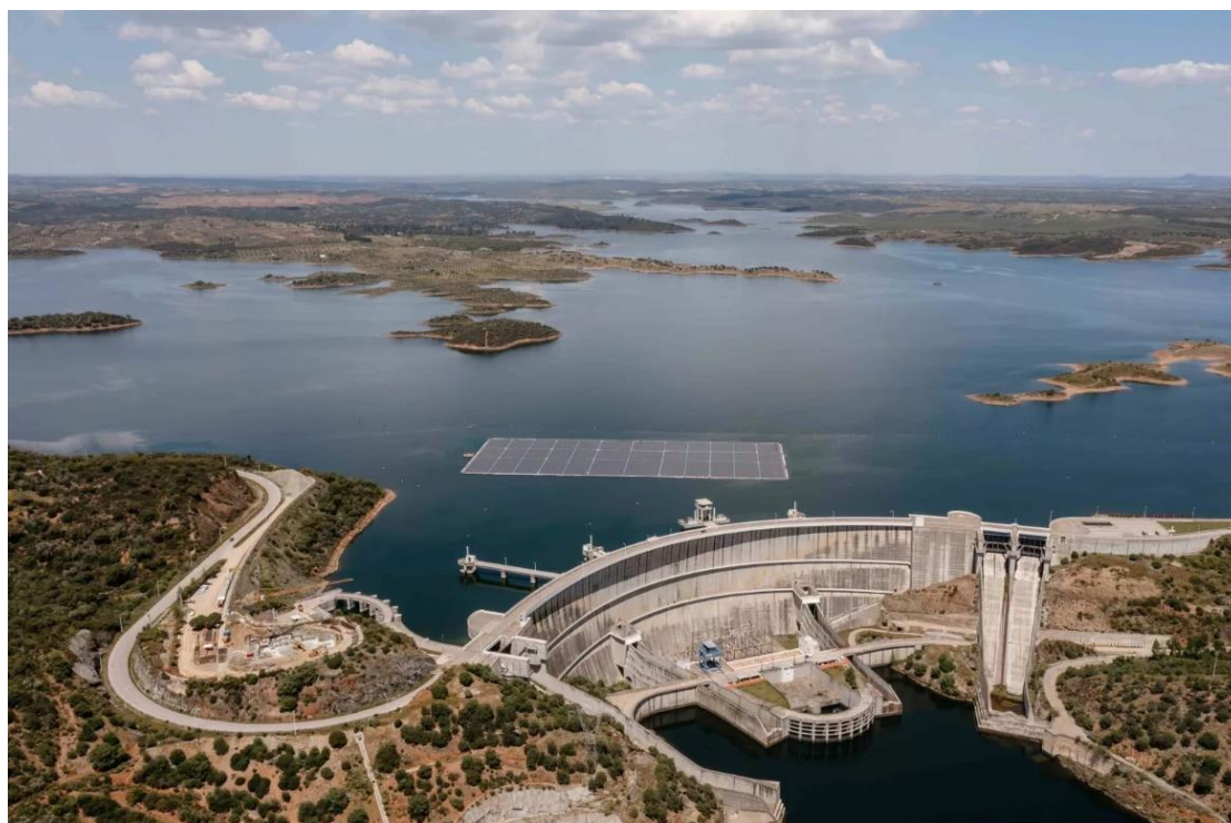
Slika 5.3 FPV/RHE sustav Alqueva, Portugal [29]
