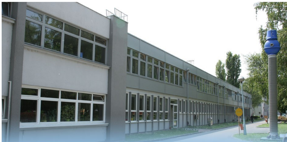
Slika 6. Vanjski izgled poduzeća KONČAR - Mjerni transformatori [7]
