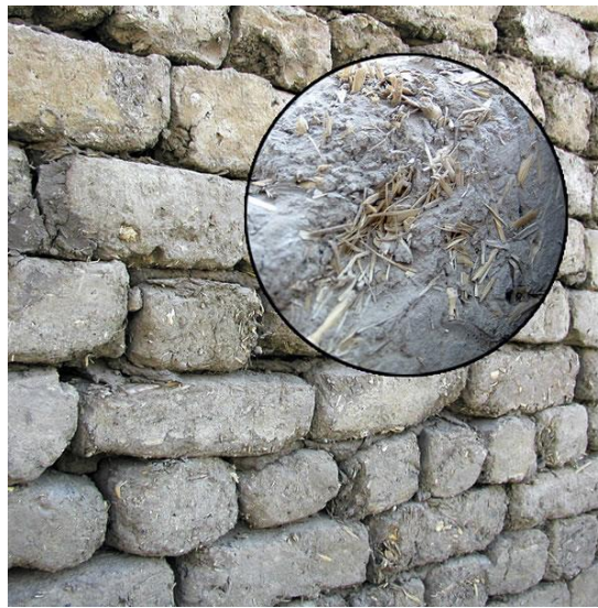
Slika 22. Sušena opeka napravljena od gline i slame [68]
