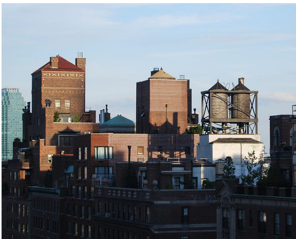
Slika 2. Spremnici na krovu zgrade, New York
