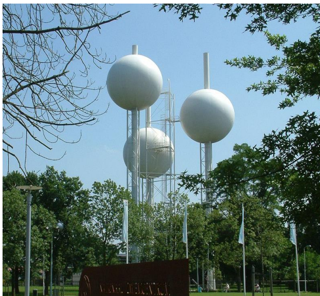
Slika 6. Sferni vodotornjevi, Eindhoven Nizozemska
