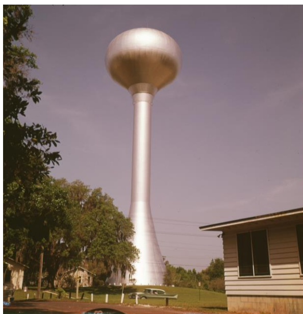
Slika 29. Primjer samostojećeg stupa s konusnim dnom
