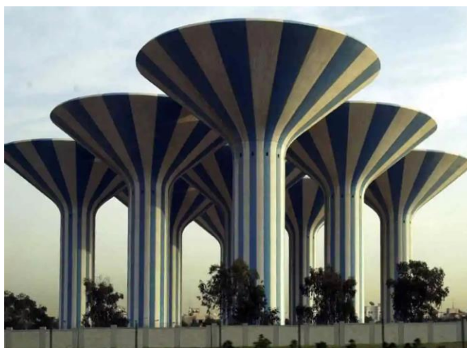
Slika 5 . Vodotornjevi, Kuwait City
