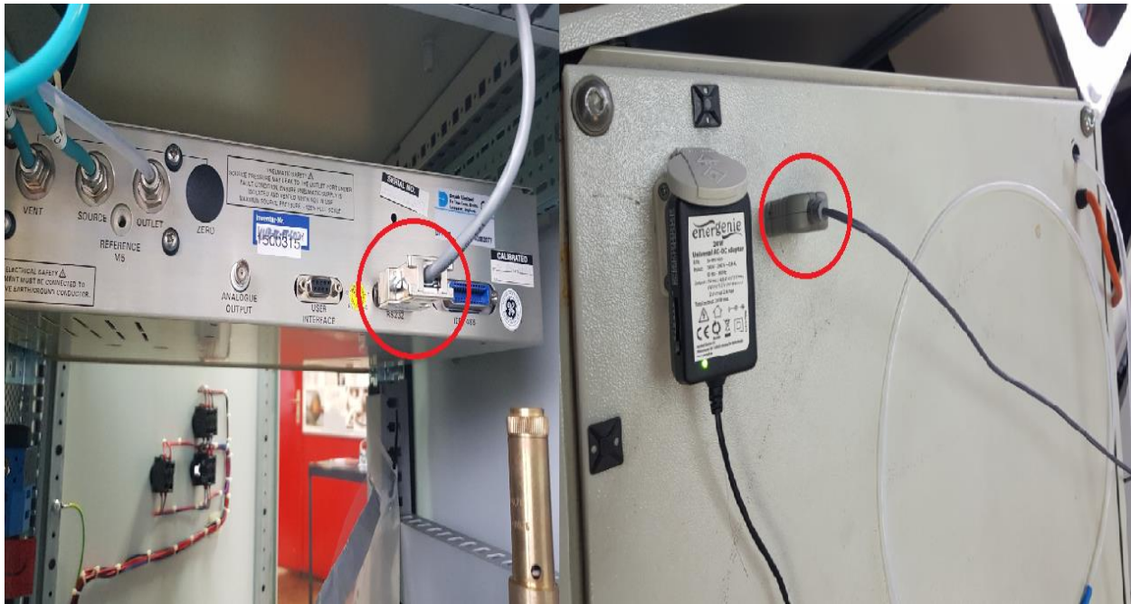
Slika 43. Spoj prijenosnog računala na priključak RS232
