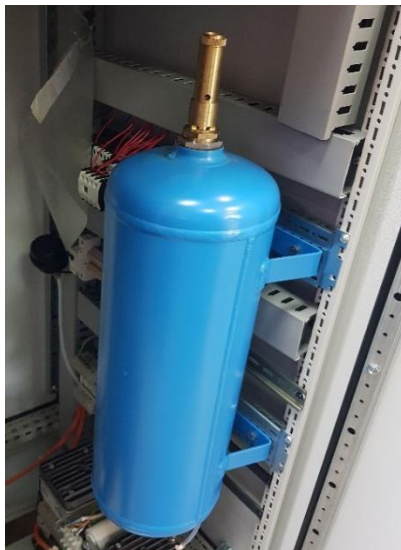
Slika 26. Tlačni spremnik sa zrakom
