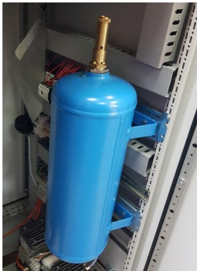
Slika 26. Tlačni spremnik sa zrakom
