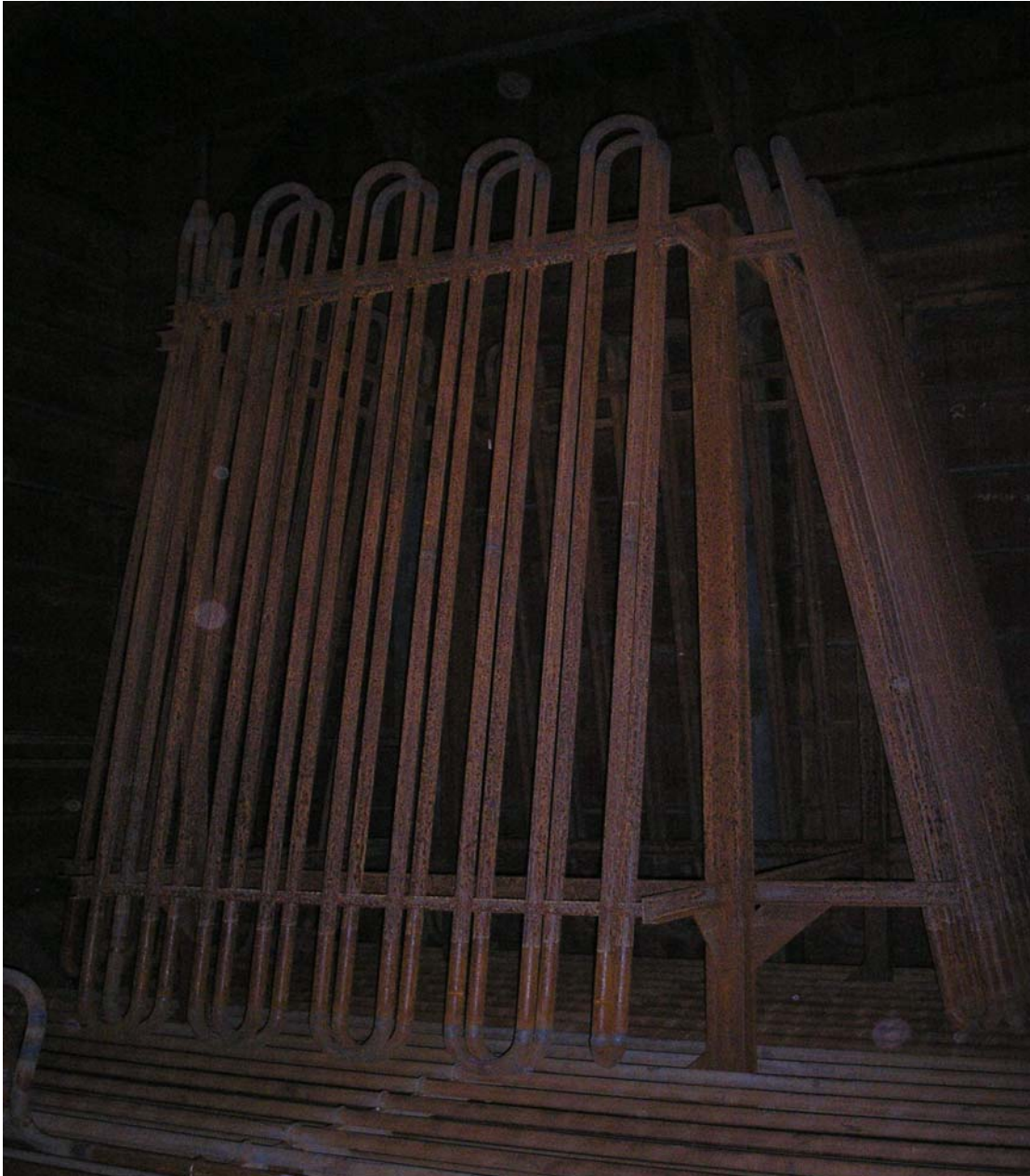
Slika 4 Cjevovod sustava grijanja tereta
