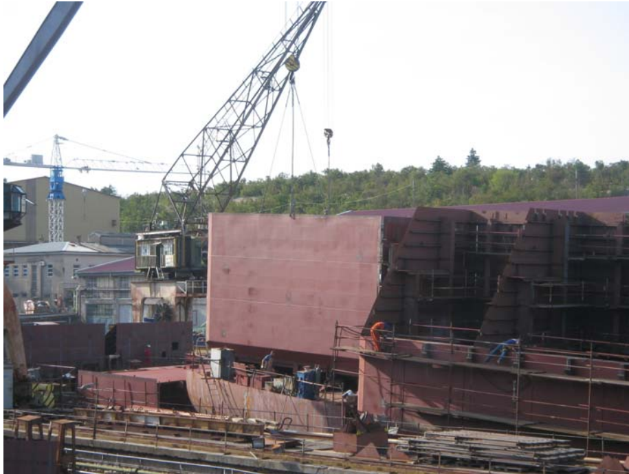
Slika 42 Montaža bloka tanka tereta br. 1 na navozu
