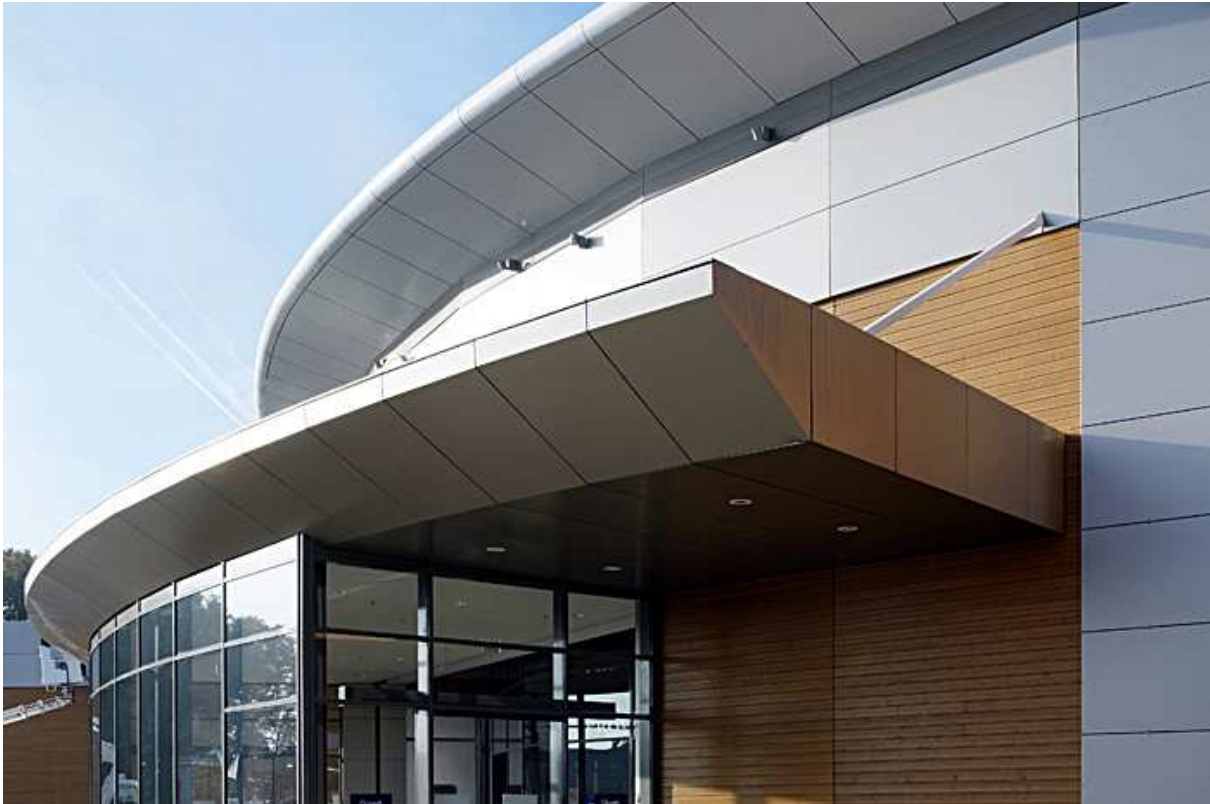
Slika 2. Izgled samoventilirajuće fasade [2]
