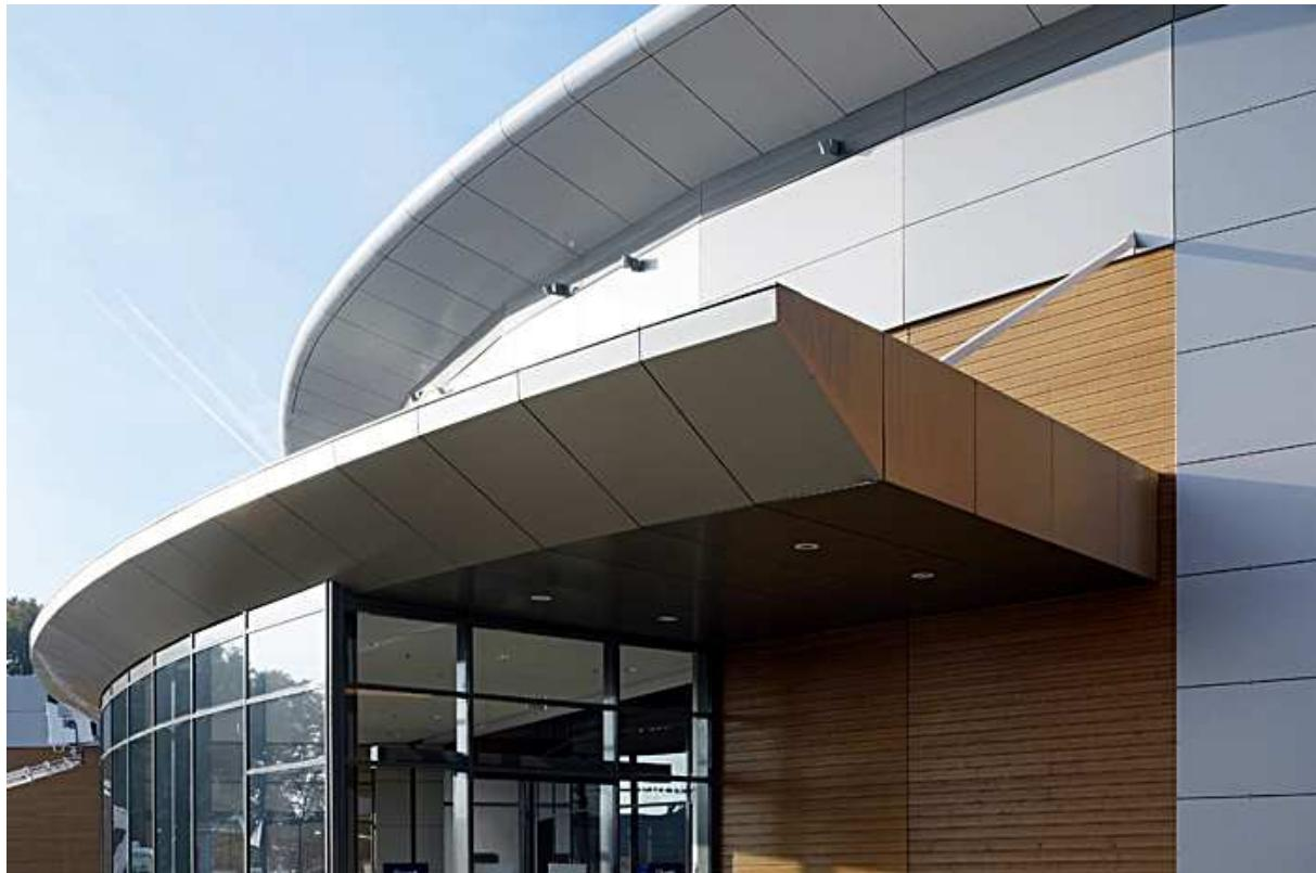
Slika 2. Izgled samoventilirajuće fasade [2]
