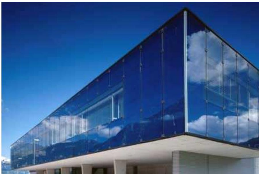
Slika 1. Pilkington - Ouješene i ventilirane fasade [1]
