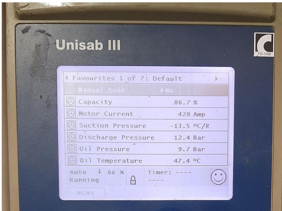
*Slika 6 Očitanje radnih parametara kompresora posrednog rashladnog sustava*
